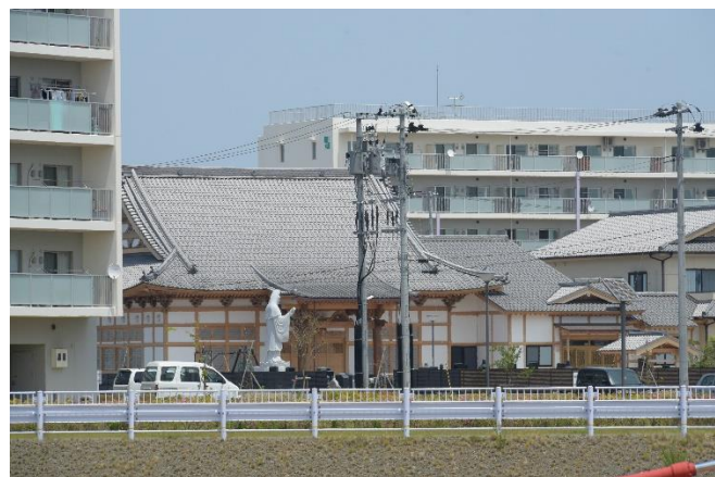
名取市、5mの盛り土の上に建った、復興住宅と、寺。住宅の1階は居住しない構造。
